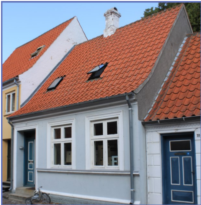
Tag med skalk—svaj fornedet på taget.
